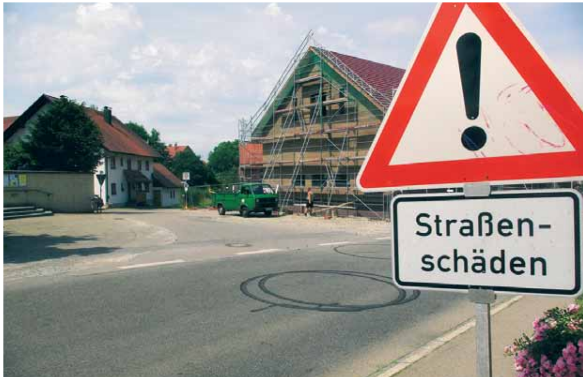
Das derzeit im Bau befindliche Dorfgemeinschaftshaus in Deuchelried hat die Ortsmitte bereits verändert. Jetzt wird auch noch der Dorfplatz drumherum gestaltet. SZ-FOTOS: KLOSE
